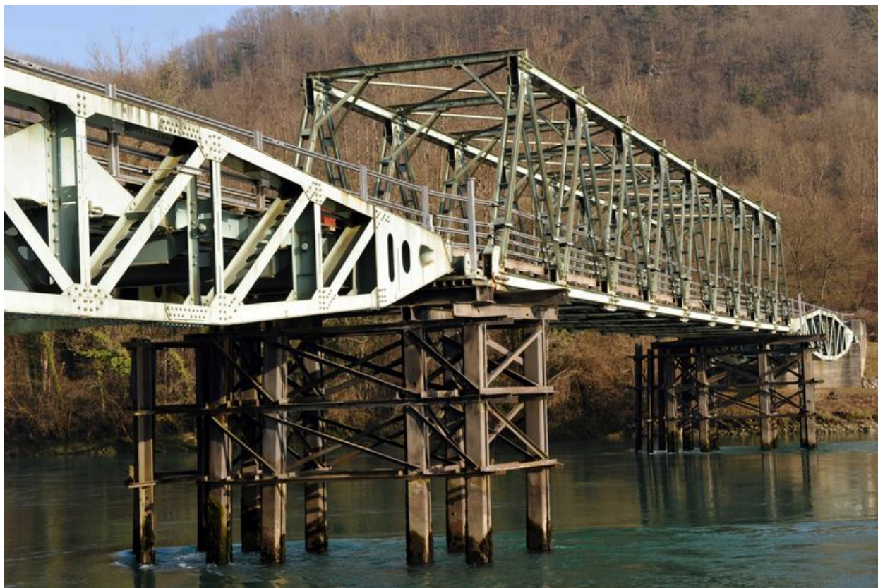
Vue du pont routier dit pont de Pyrimont ou passerelle de Surjoux (Ain) ; pont à poutre en treillis (début des années 1950)
