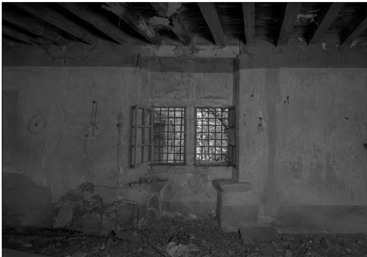
Logis de l'aile gauche, détail : fenêtre à coussièges.
