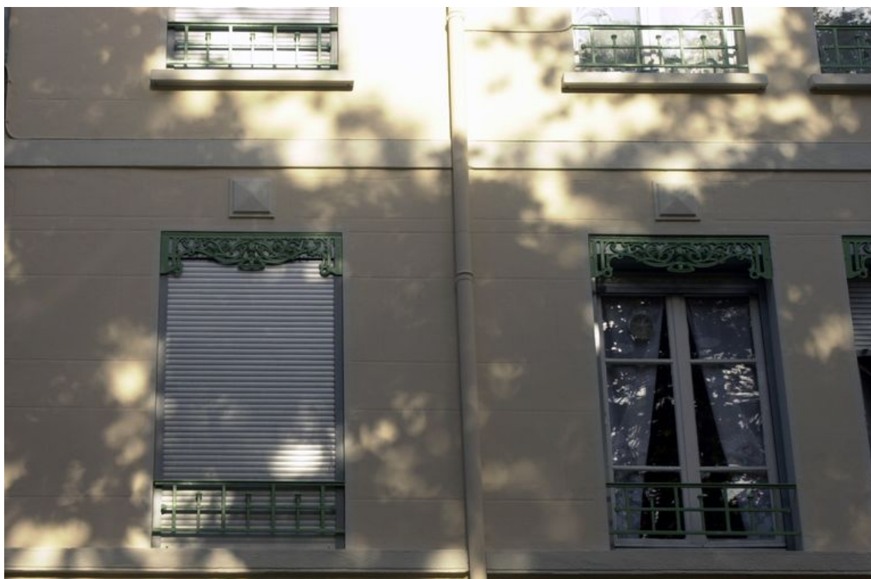
Elévation principale. Détail des baies
