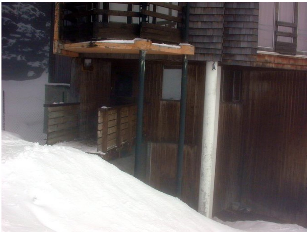
L'entrée amont, au nord
