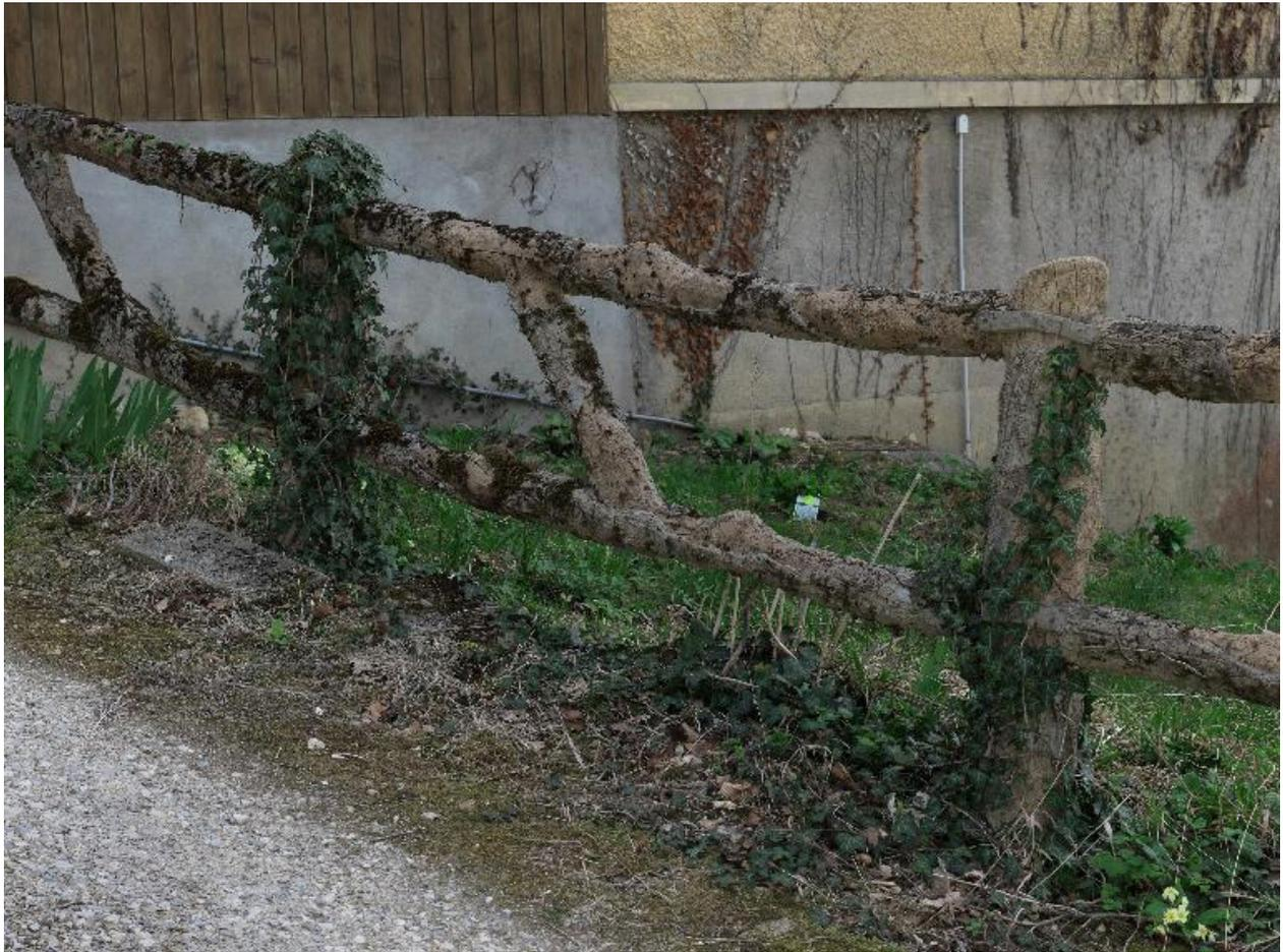
Détail d'une barrière en béton moulé
