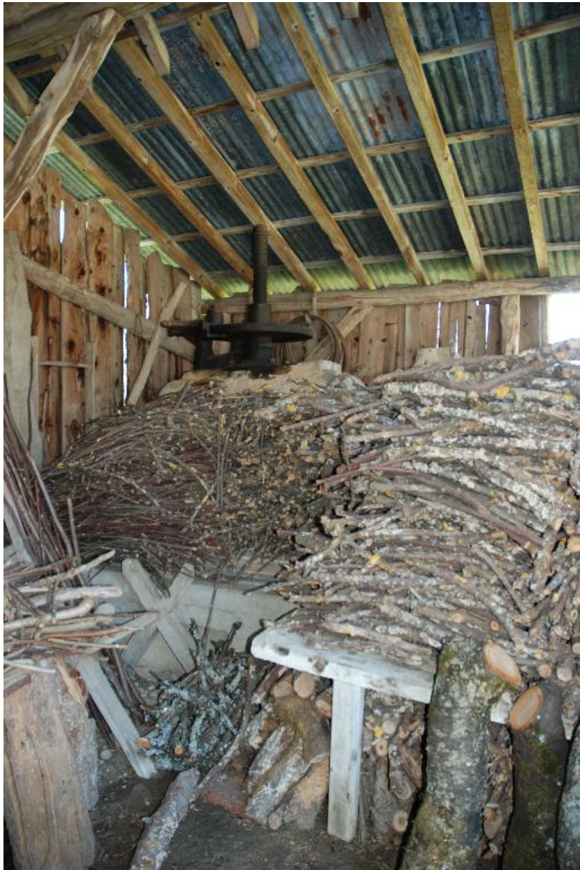
Vue intérieure de la ferme avec pressoir masqué par du bois.
