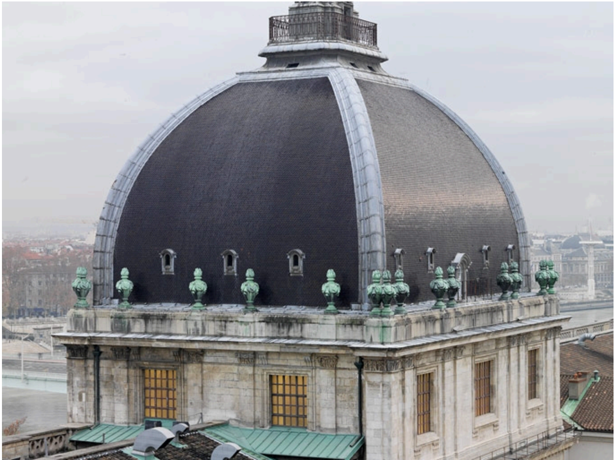
Le dôme Soufflot. Détail depuis le nord-ouest
