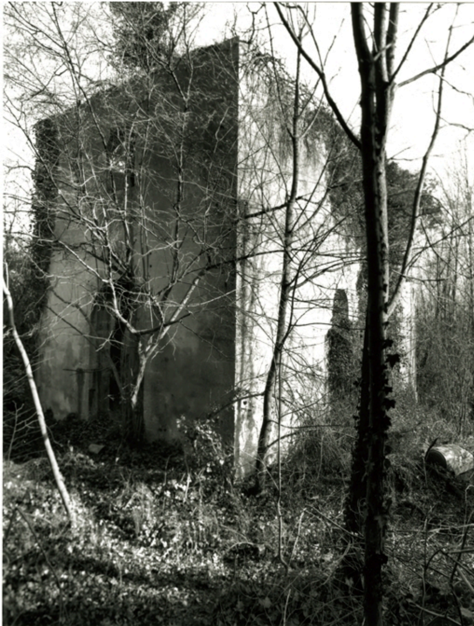
Bâtiment des machines de la fonderie
