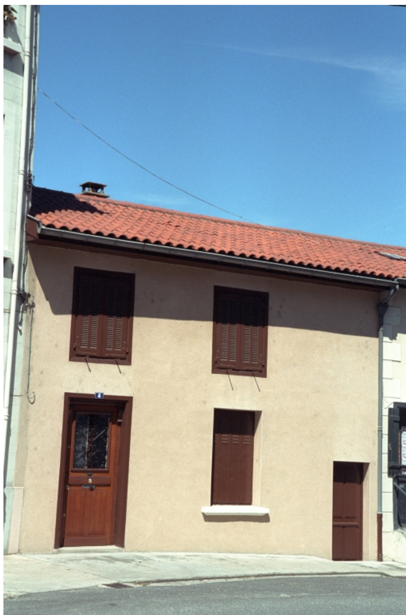
Boën, îlot 12, Clermont (rue de) 4. Vue générale de la façade sur rue.
