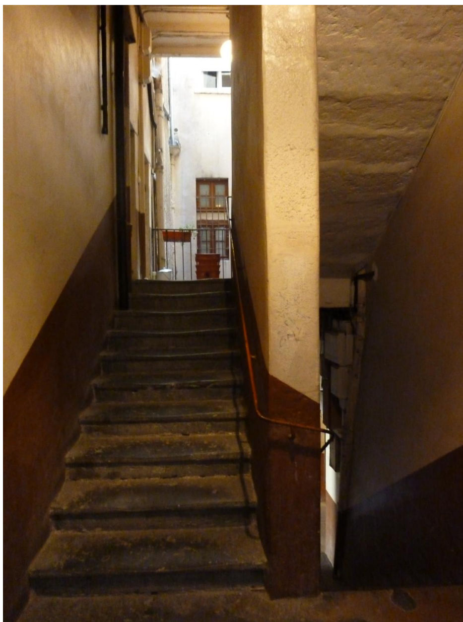
Vue de l'escalier à mur noyau plein
