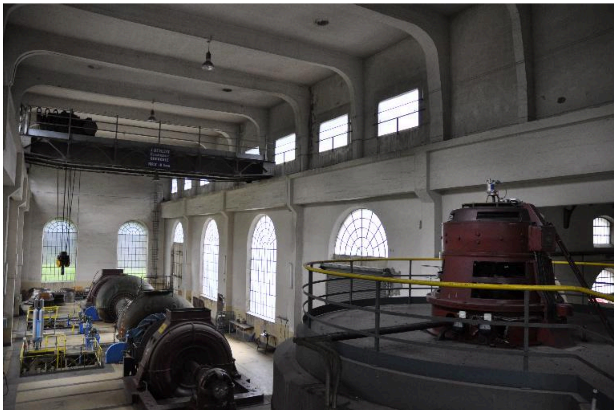
Vue d'ensemble du bâtiment des Clavaux, charpente en béton
