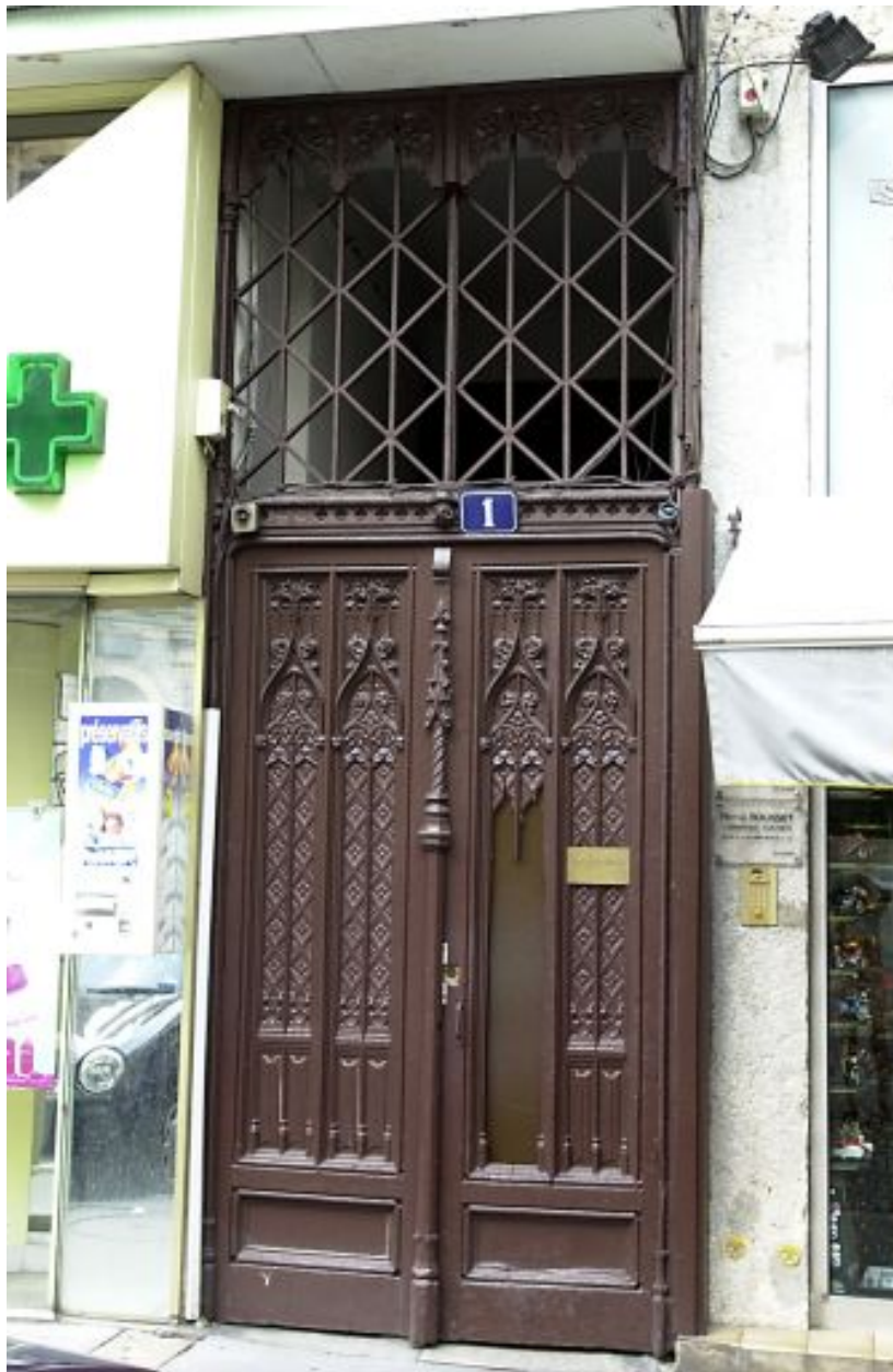
Façade place Saint-Nizier, détail de la porte
