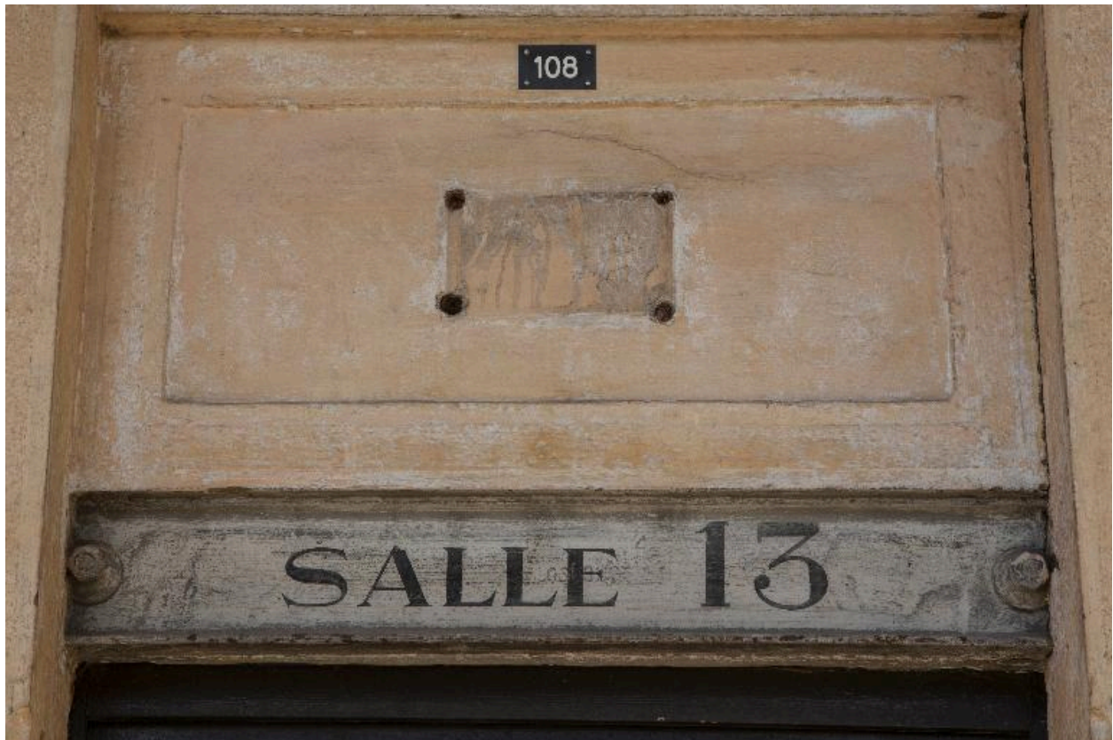
Bâtiment A. Imposte des salles : salle 13
