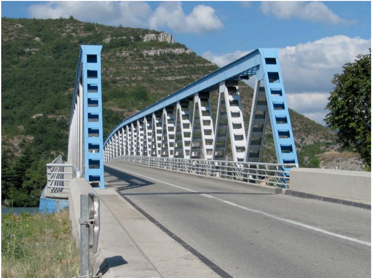
Vue générale, de dessus, structure et chaussée (depuis la rive gauche)
