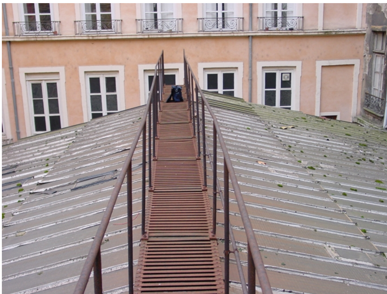
Passerelle de la verrière
