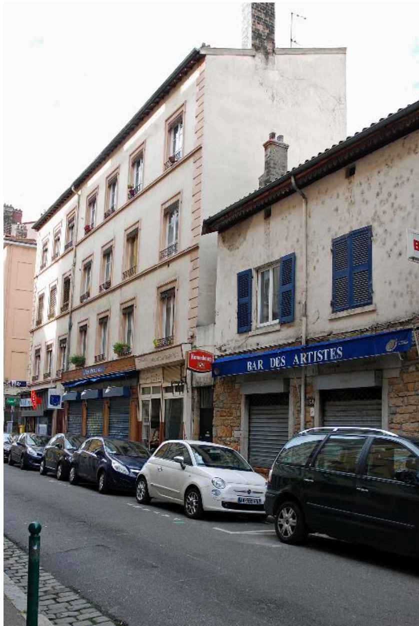
Élévation latérale est, rue Sébastien-Gryphe
