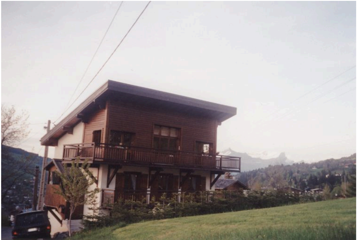
Façade antérieure. Etat en 1996
