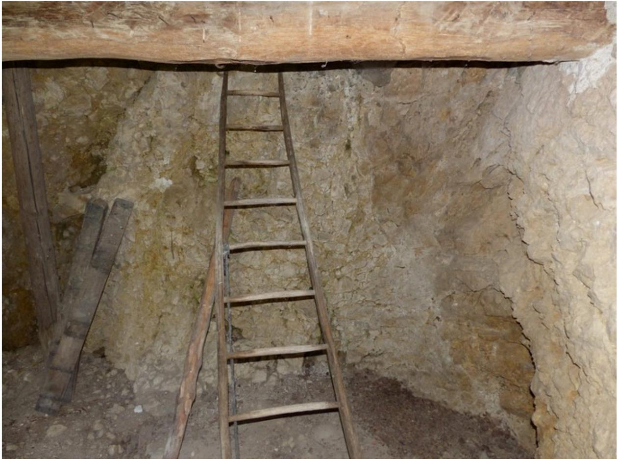
Premier étage de soubassement, resserre. Angle nord-est, maçonnerie assise sur le rocher.
