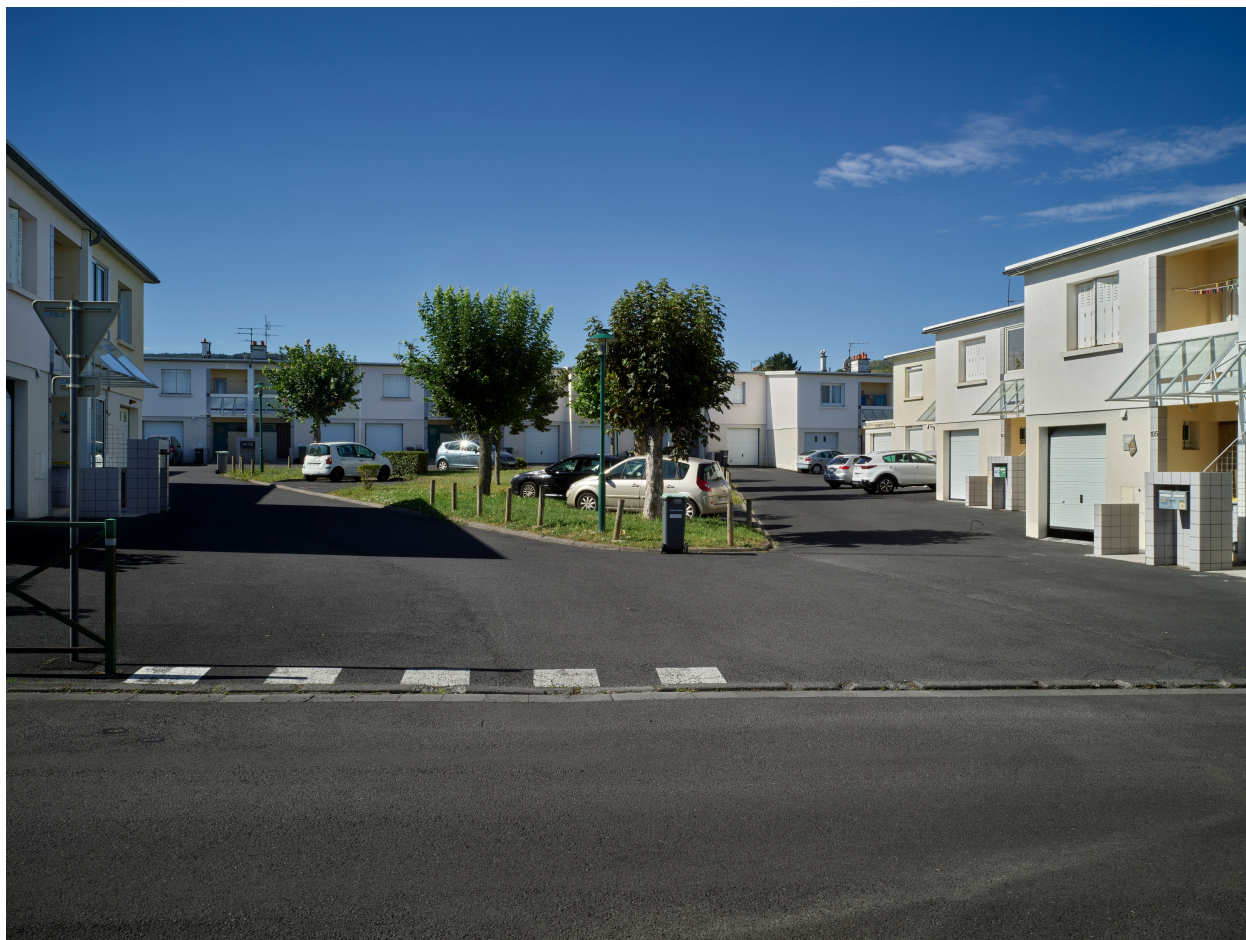
Vue d'ensemble de l'îlot Paul-Valéry, en bordure de la rue du Huit-Mai.
