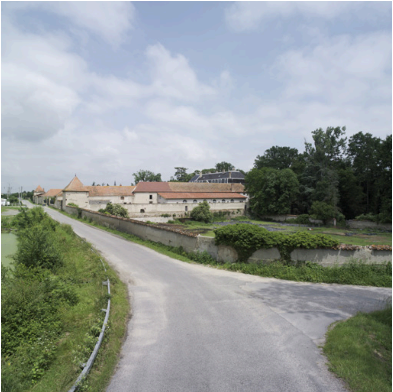
Vue générale depuis le sud (état en 2008, après travaux).
