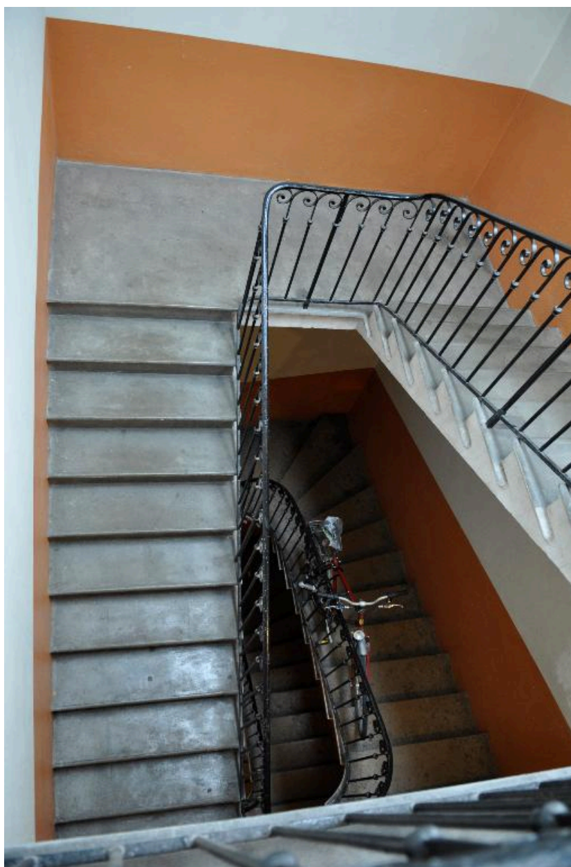
Vue intérieure : révolutions supérieures de l'escalier, surélevées en béton
