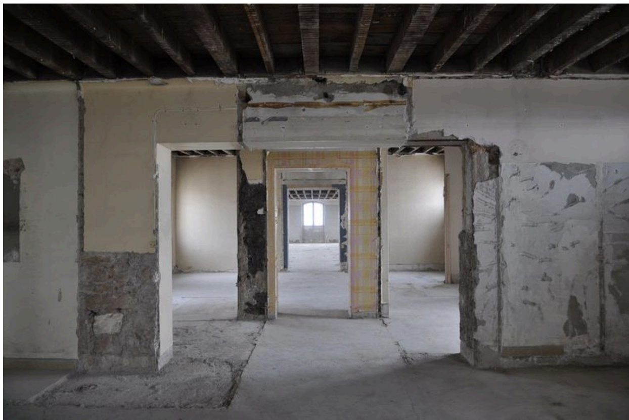
Vue des combles, durant les travaux de décembre 2010.
