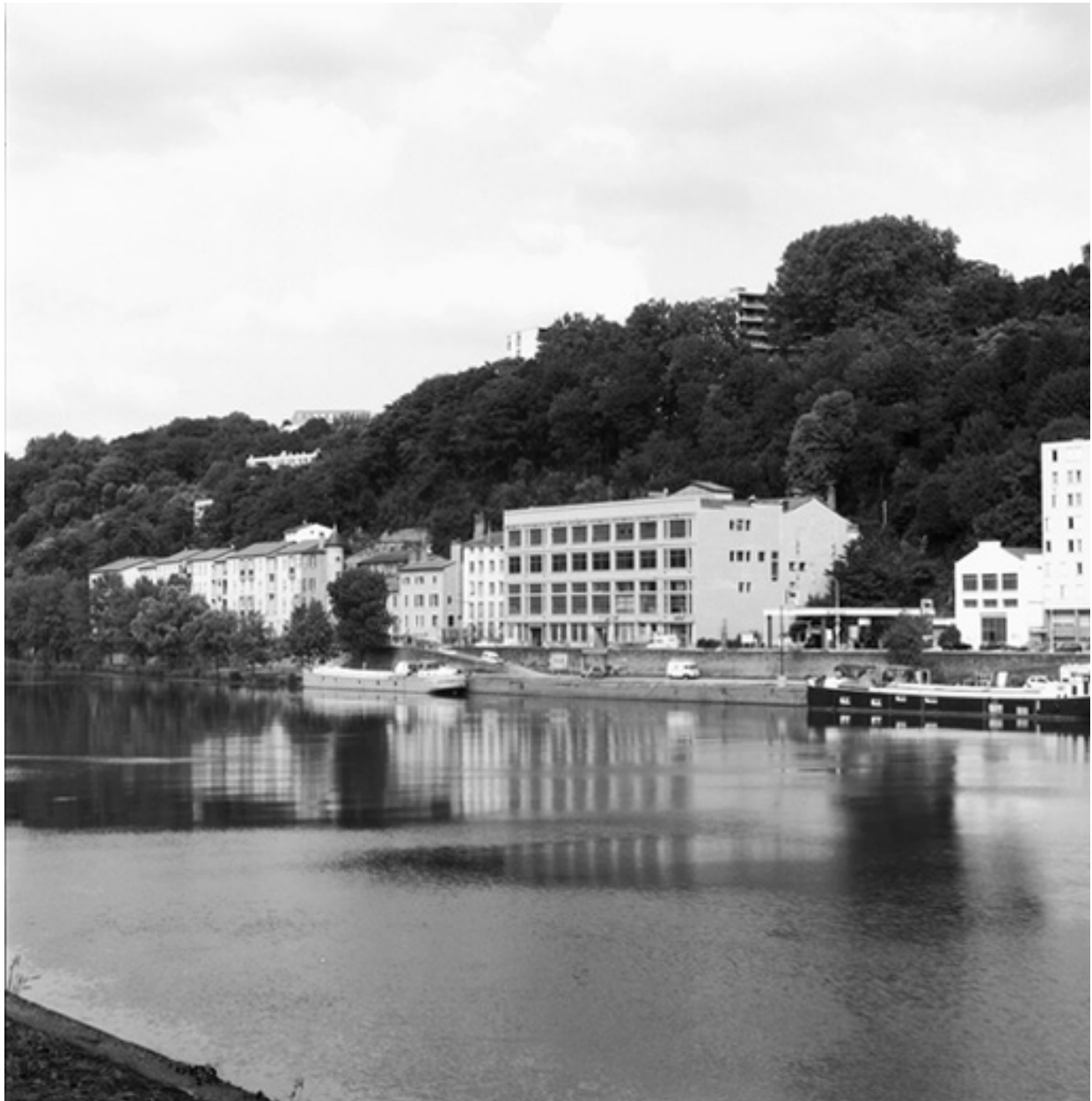
Vue d'ensemble ouest
