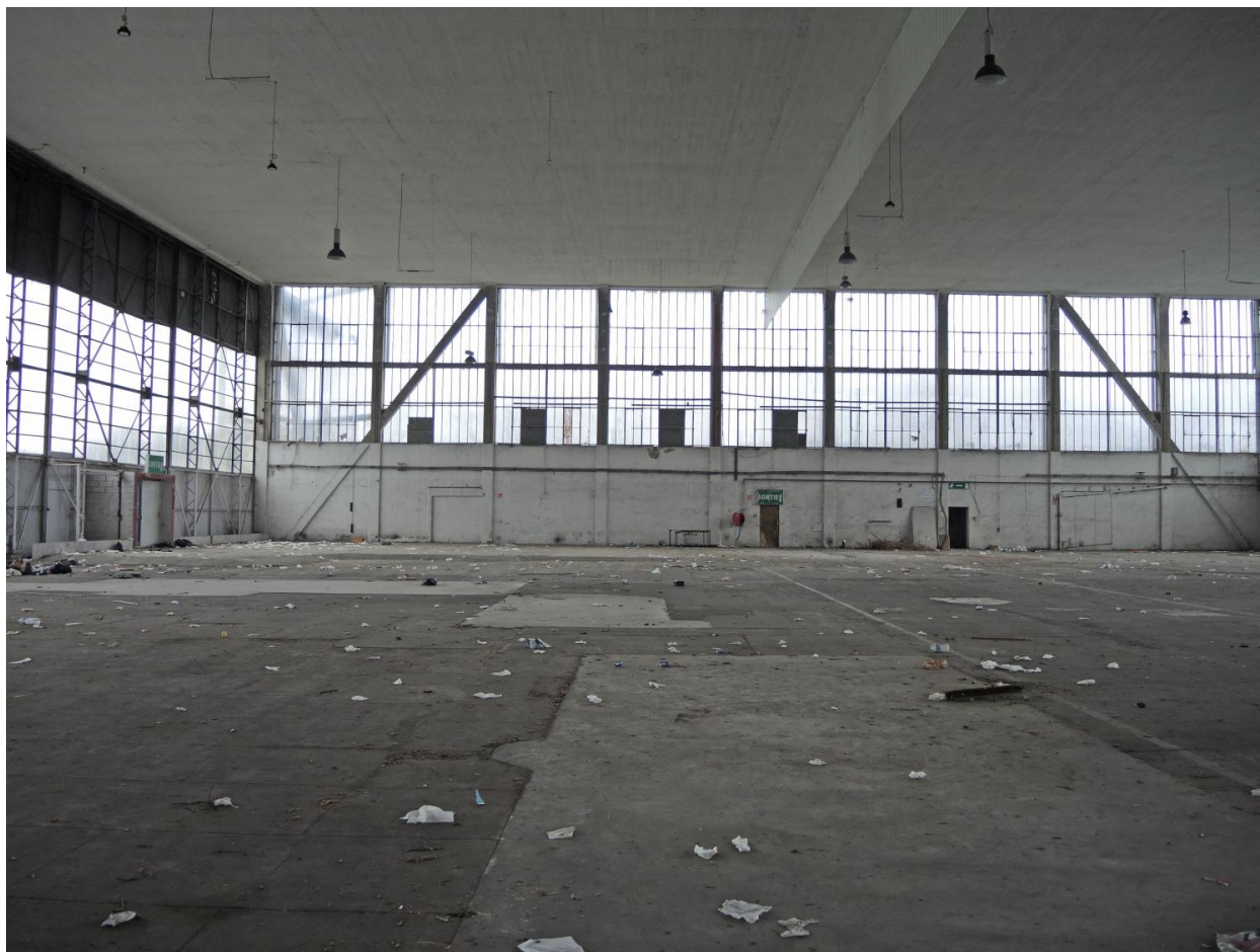
Hangar VI photo vue d'intérieur
