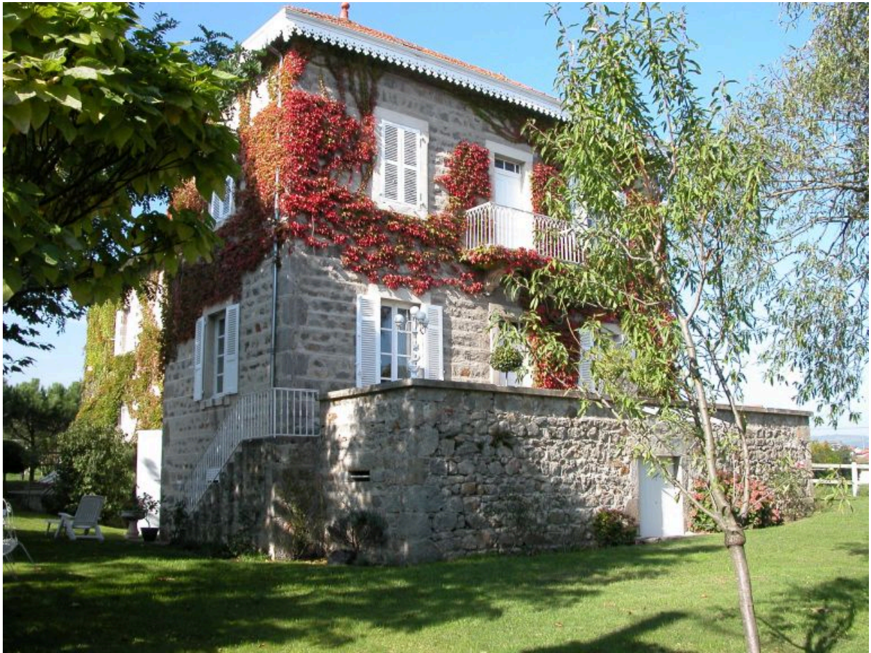
Vue d'ensemble du logis depuis le sud-est.
