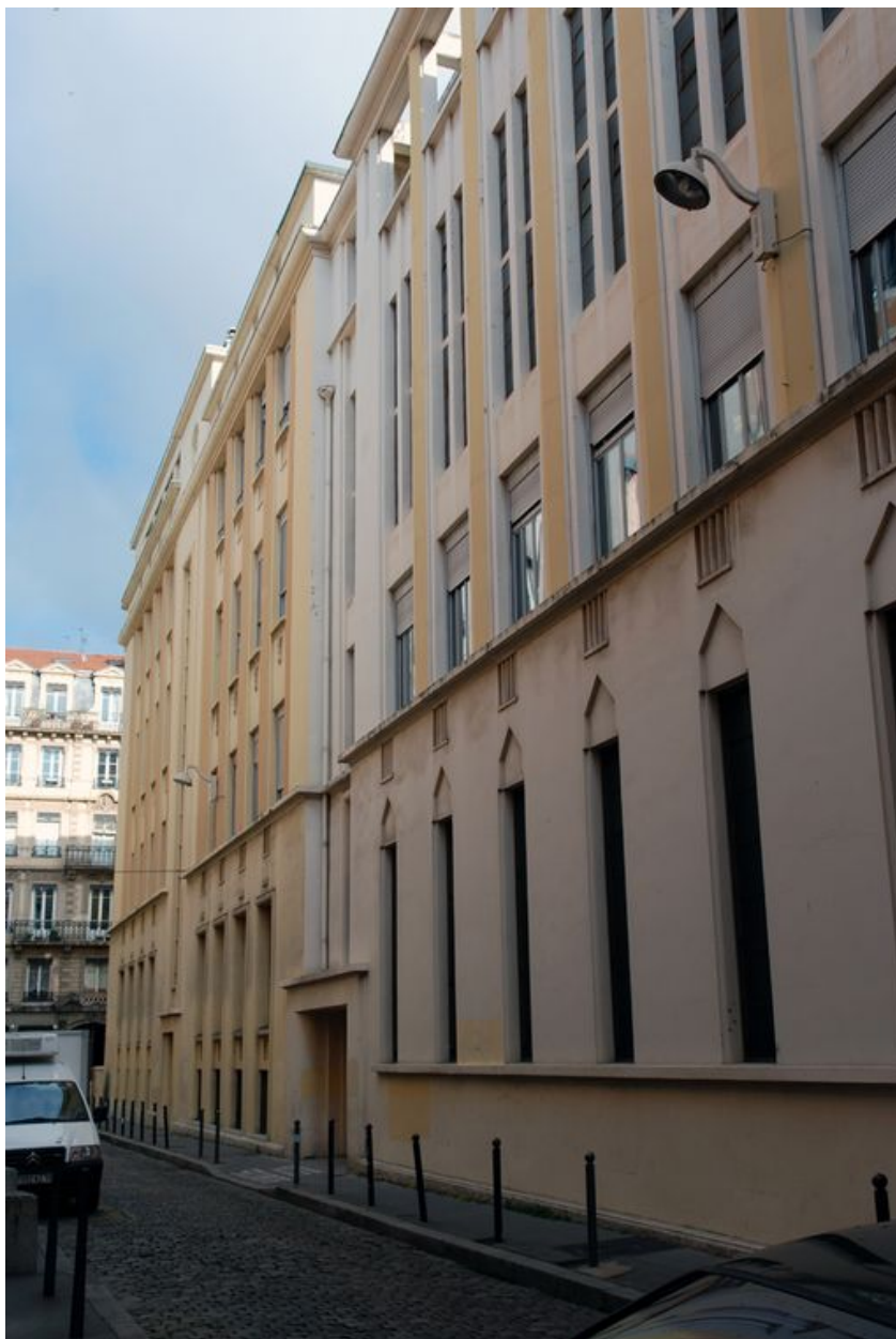
Elévation latérale sud, rue Tony-Tollet, depuis l'ouest
