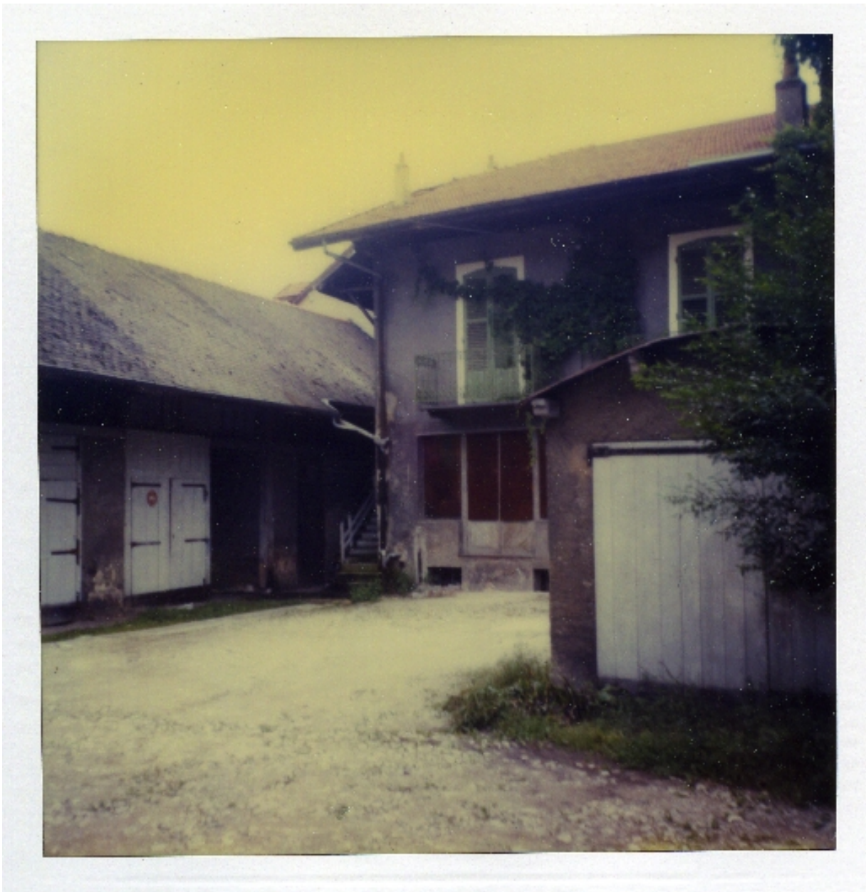
Maison ouest, façade sur cour
