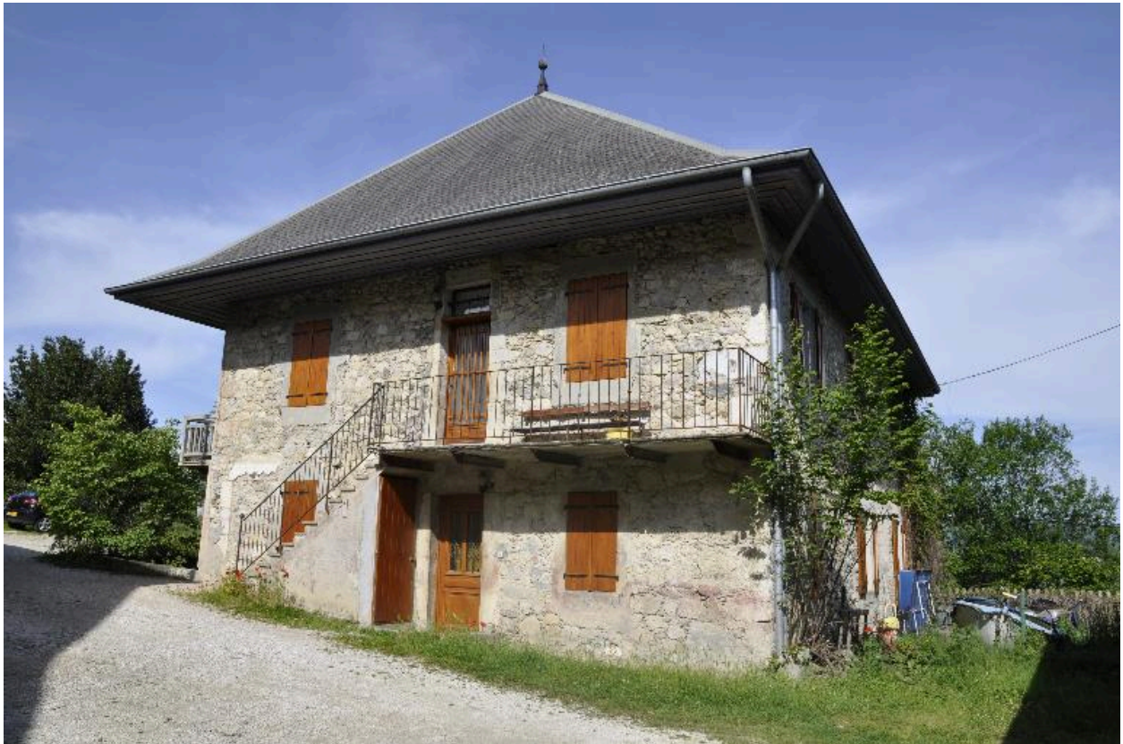
Vue d'ensemble : élévation est.
