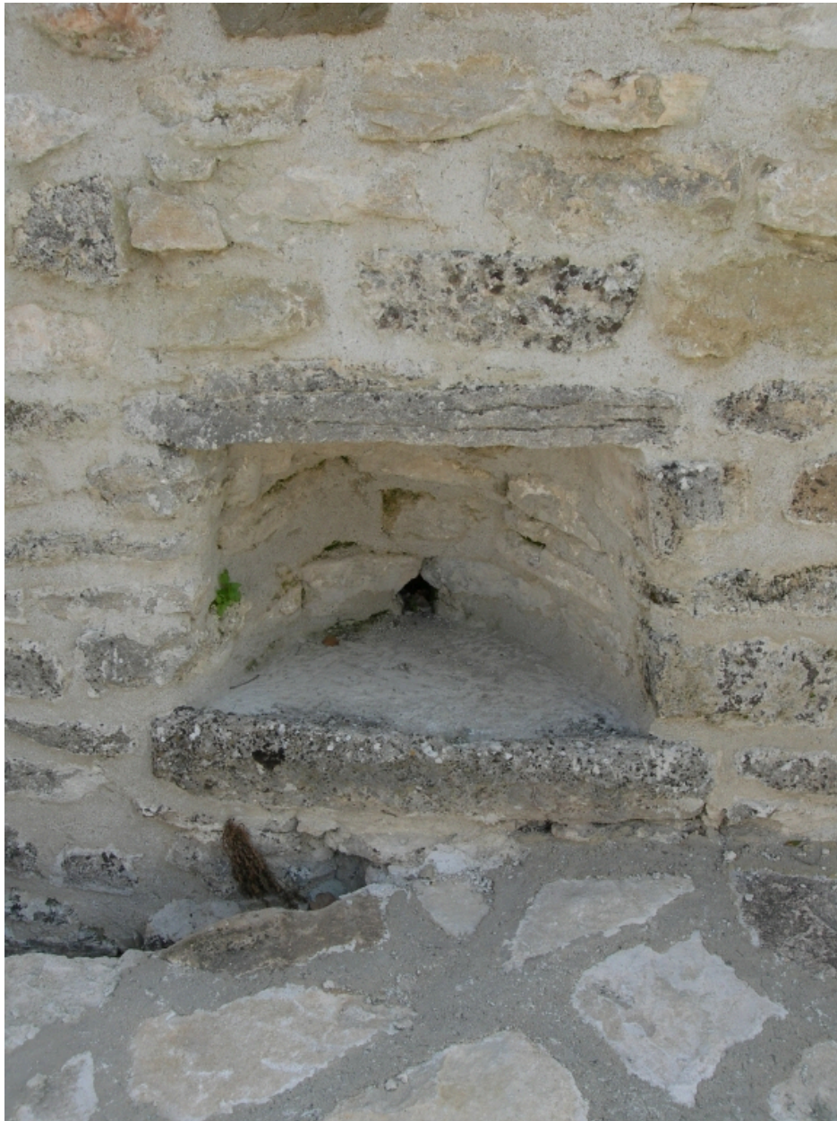
Chapelle restaurée, lavabo dans un vestige du mur sud de la nef.
