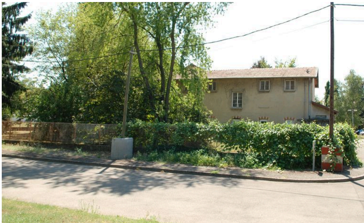
Bâtiment 456-457, aile nord, façade nord
