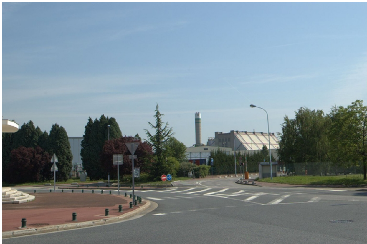
Vue d'ensemble nord-ouest du port
