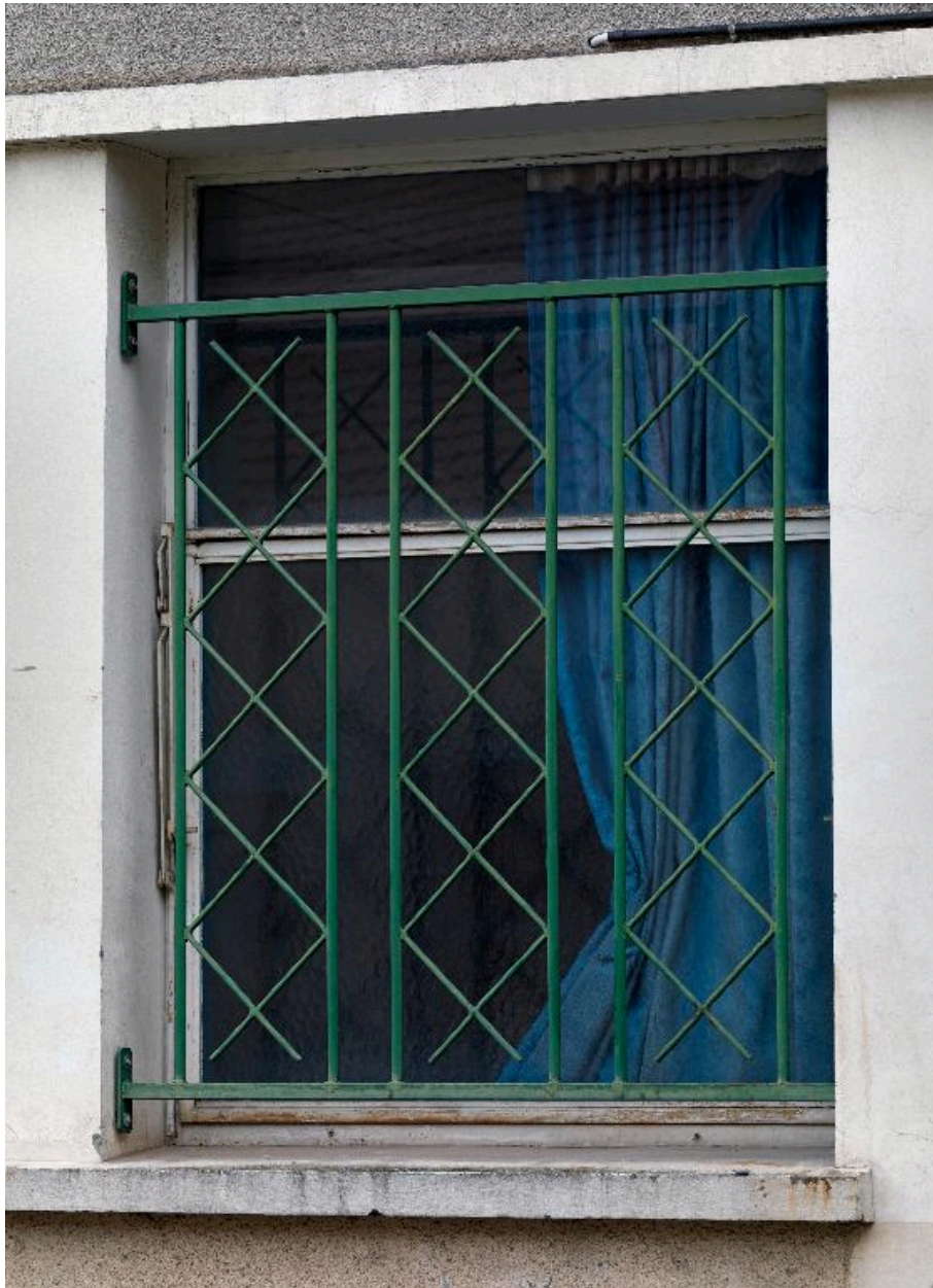
Bâtiment E, fenêtre façade côté cour
