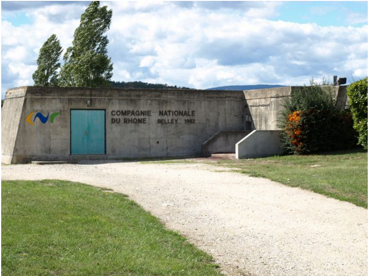
Façade, vue partielle : nom et date portés
