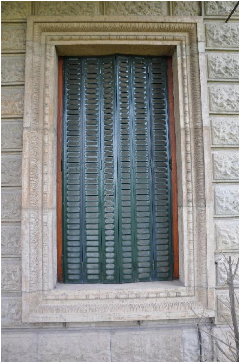
Détail d'un encadrement de baie
