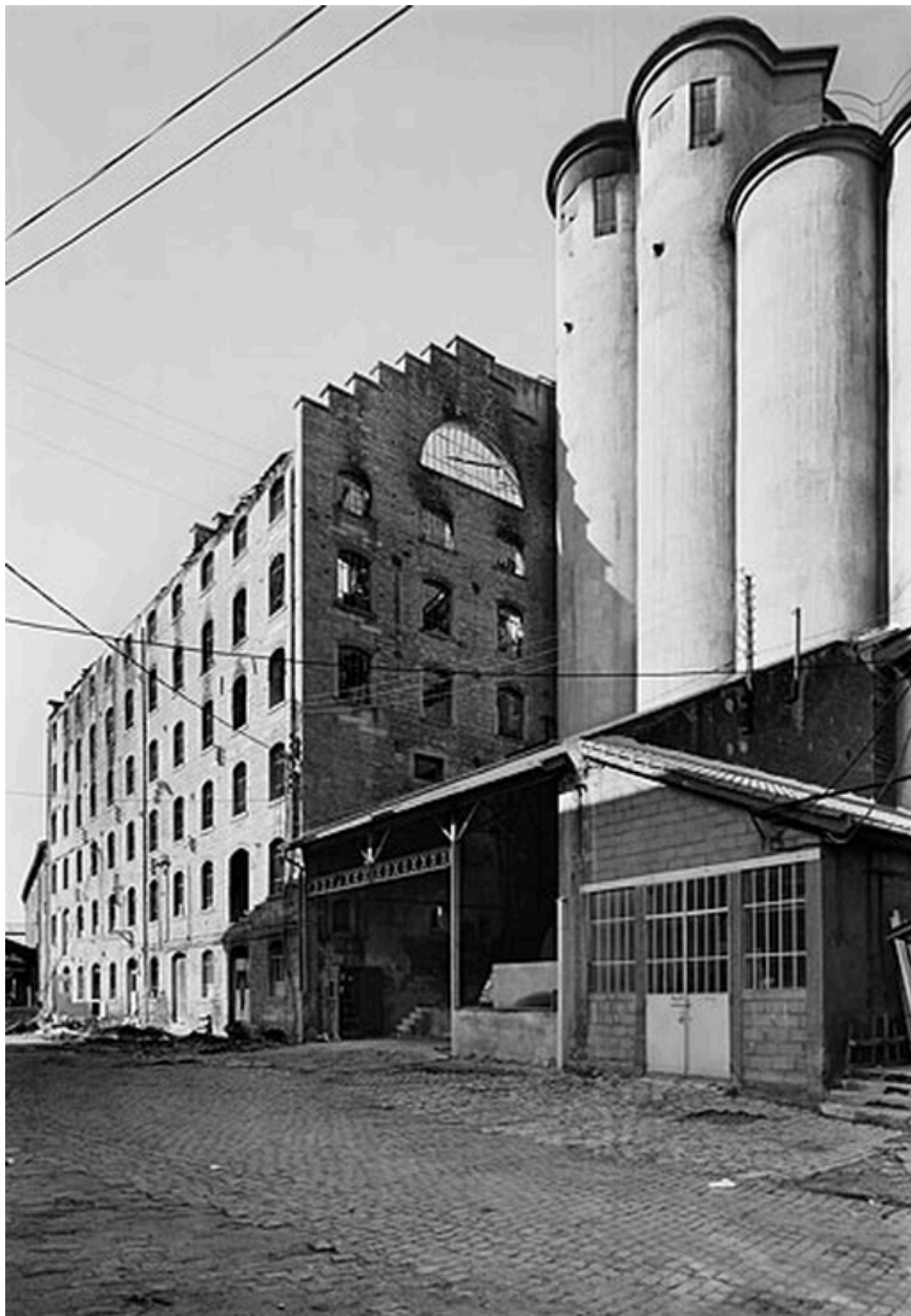
Vue de l'est avec les silos cylindriques en béton
