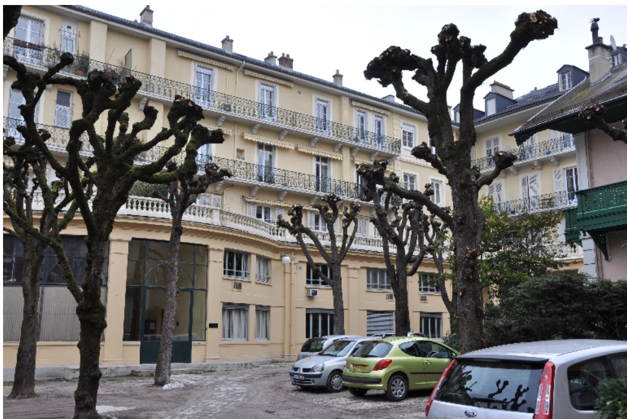
Aile : façade sur cour
