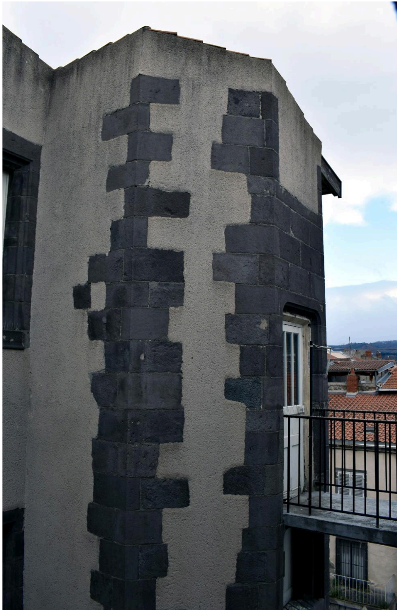
Tour d'escalier : partie supérieure
