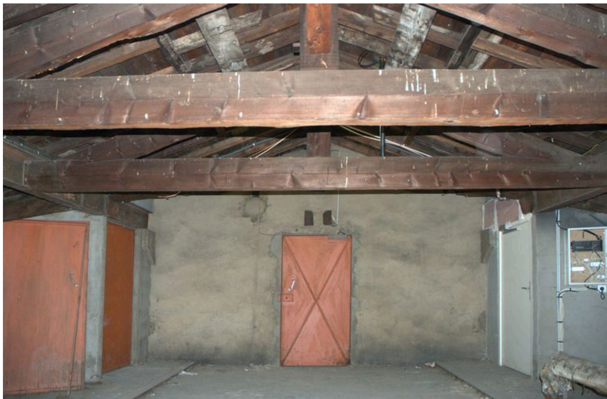
Combles de l'ancien quartier des agitées
