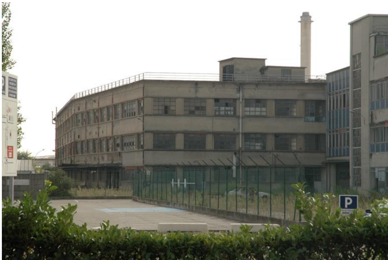
Bâtiment avant démolition
