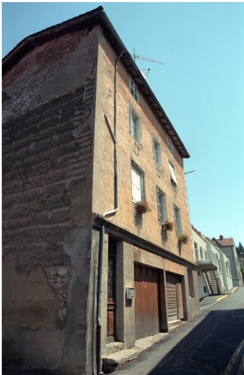
Boën, îlot 19, Alsace Lorraine (rue) 6. Vue générale de la façade sur rue.
