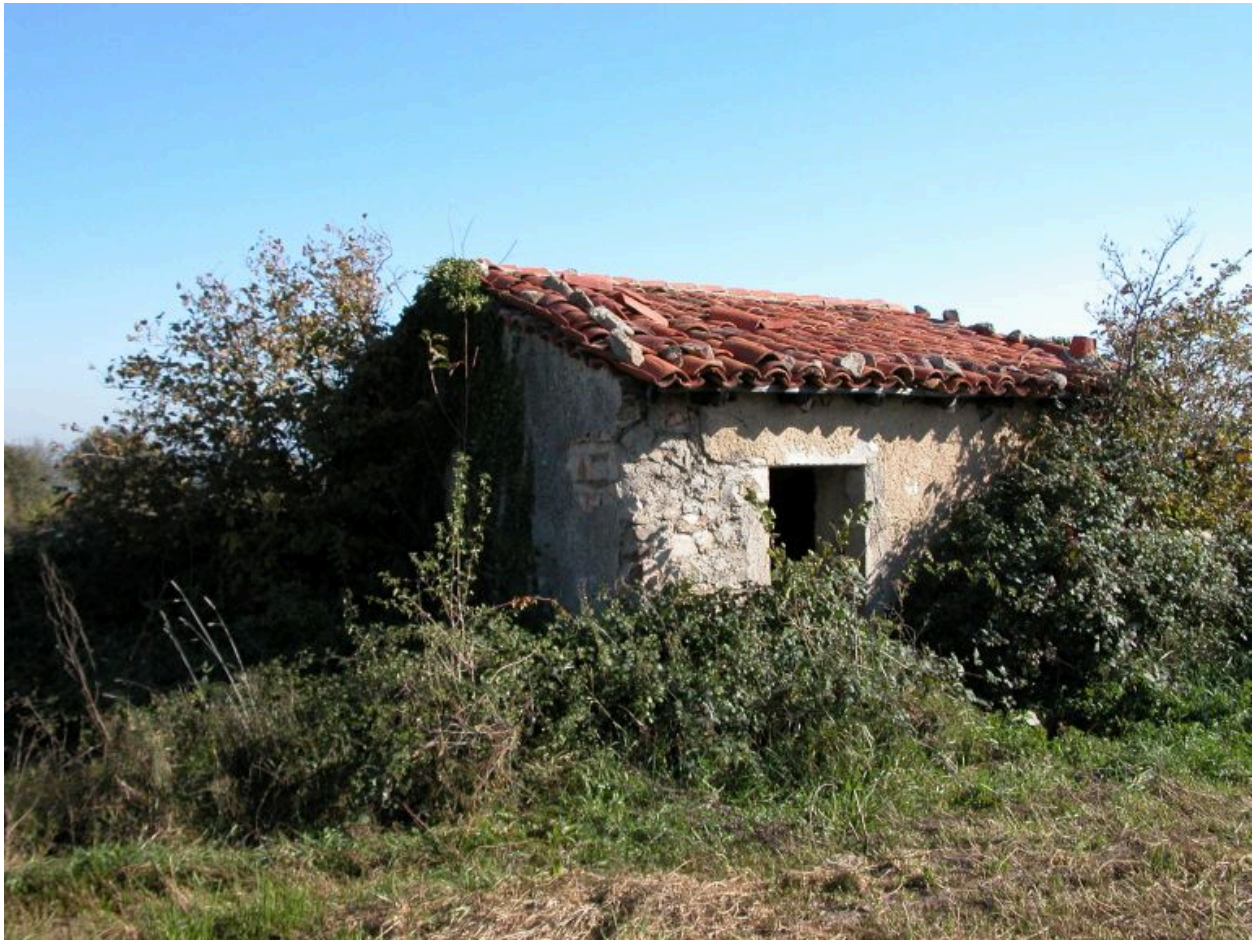
Vue d'ensemble de la loge côté intérieur du clos.
