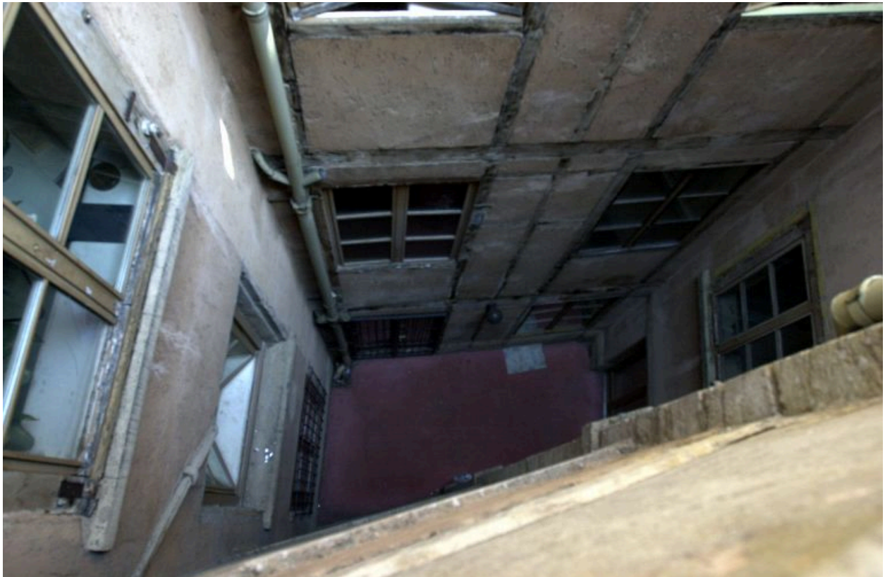
Cour vue du haut de l'escalier, le premier corps étant à gauche
