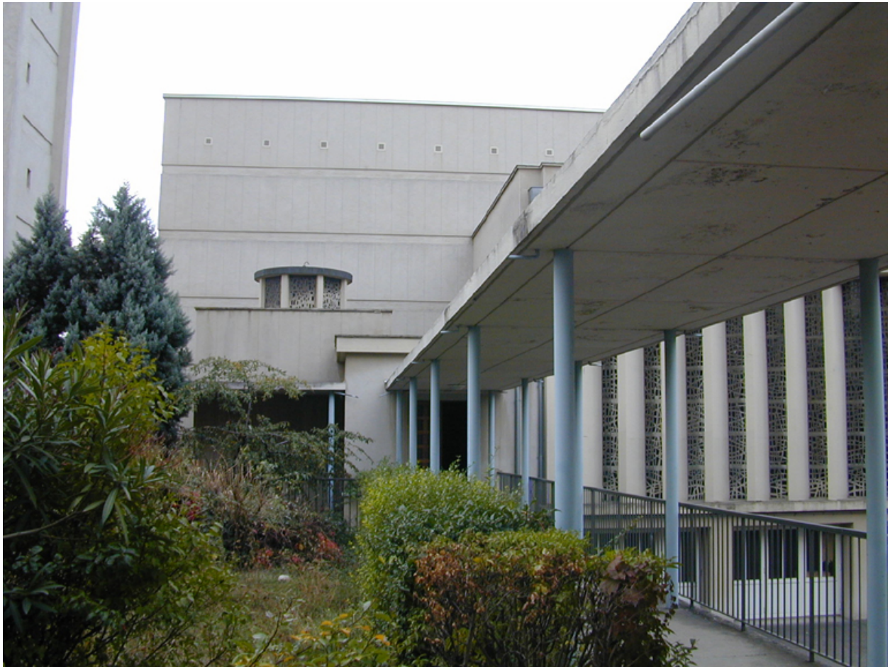
Vue de la galerie menant du presbytère à l'église, depuis le nord
