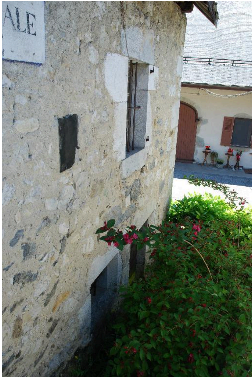
Vue partielle de la façade arrière du logis
