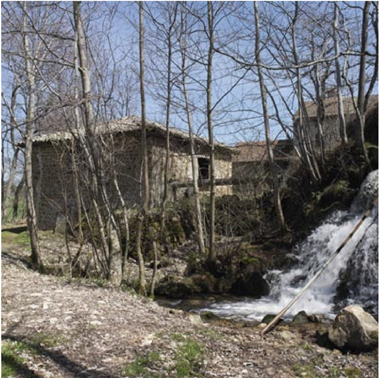
Vue d'ensemble du moulin de trois-quarts sud-ouest
