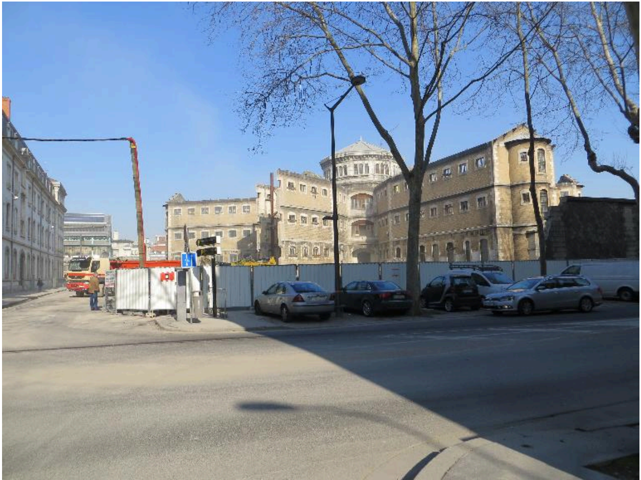
Etat au 19 février 2013 : vue d'ensemble depuis l'angle du cours Suchet et de la rue Smith
