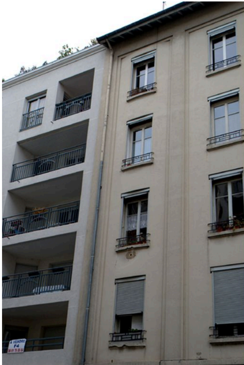
Elévation principale. Vue des deux travées de gauche
