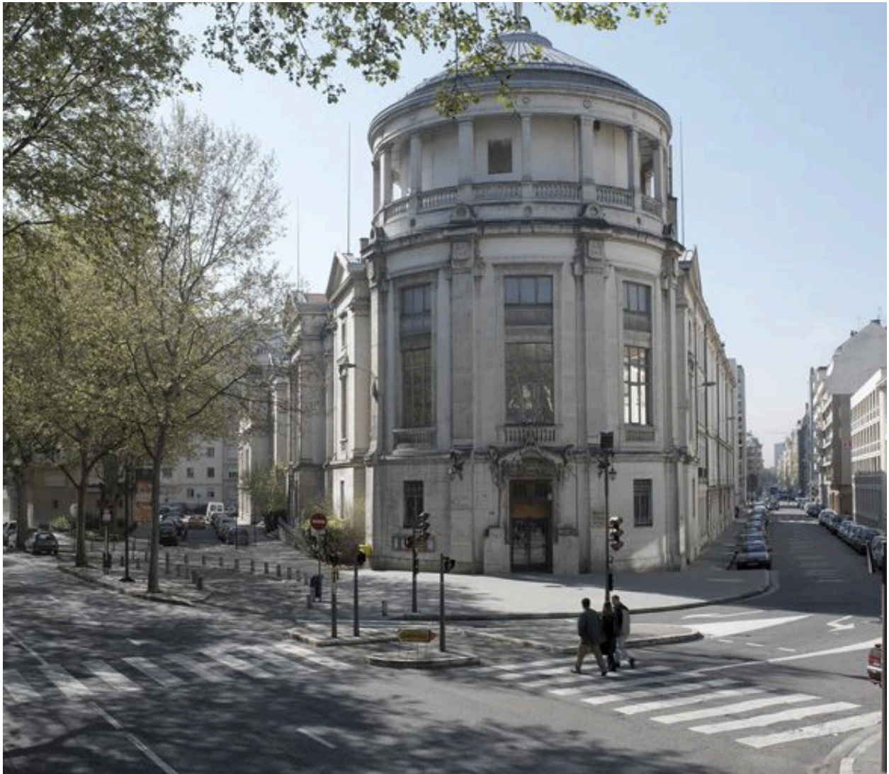
Boulevard des Belges, rue Morellet et rue Boileau à la hauteur du musée Guimet
