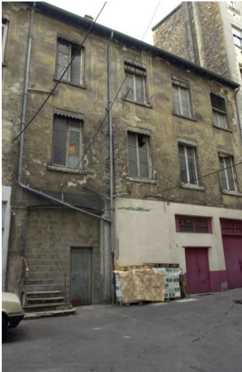
Elévation de l'immeuble sur cour
