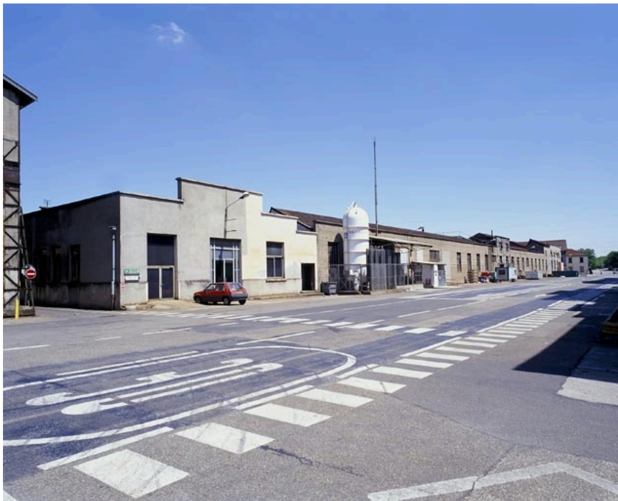
Parachèvement nord, ébardage, avenue B
